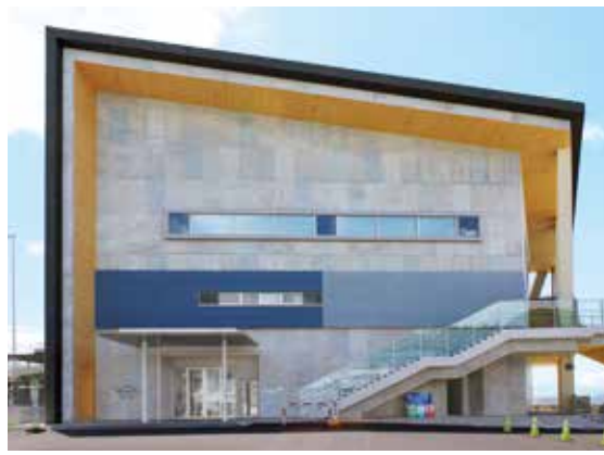
ターミナル機能に加え観光拠点、移住拠点の機能もある、小豆島坂手ポートターミナル「さかてらす」。
