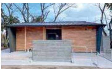
2024（令和6）年にダイハツ九州スポーツパーク大貞のトイレ改築工事を行い、入口及び室内のバリアフリー化を行った。
