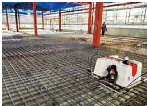
建設現場の大変な重労働である鉄筋の結束を自動で行う「鉄筋結束トモロボ」。 不安定な鉄筋の上を安定して走行できる世界唯一のロボットです。
