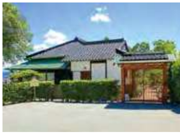
史跡丸亀城跡三の丸にある「延寿閣別館」。
