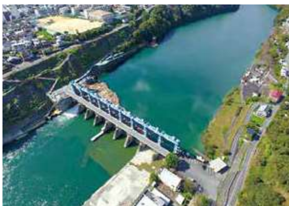
池田ダム(写真提供:独立行政法人水資源機構)
