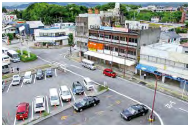
老朽化した亀山駅前
