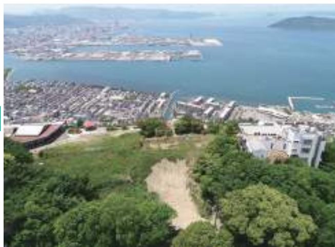
整備前(令和2年5月23日撮影)
