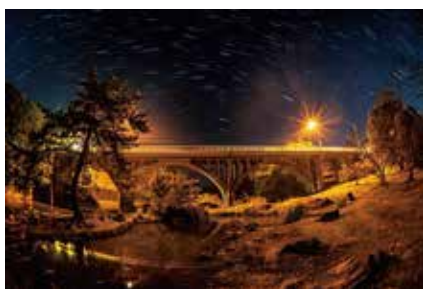
▲第1回住まいるあやがわフォトコンテスト 入選:「in the mood」(撮影 高崎彰さん) 1933(昭和8)年に竣工した「滝宮橋」。欄干も橋脚のアーチも凝った意匠が目を引きま
