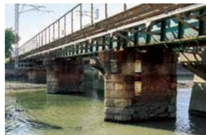
金倉川に架かる鉄橋の橋脚は1889（明治22）年の讃岐鉄道発祥の時代から使われているフランス式のレンガ積み。
