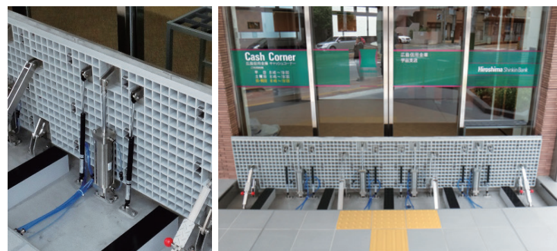
水道網圧力配管で動作する唯一の水圧シリンダ。電源が不要で停電時にも作動します。取り扱いは簡単で、万が一水源が利用できなくても、手動の補助機構を装備しています。
