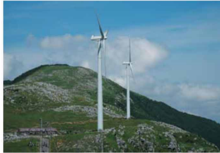
四国カルスト(風力発電所)
