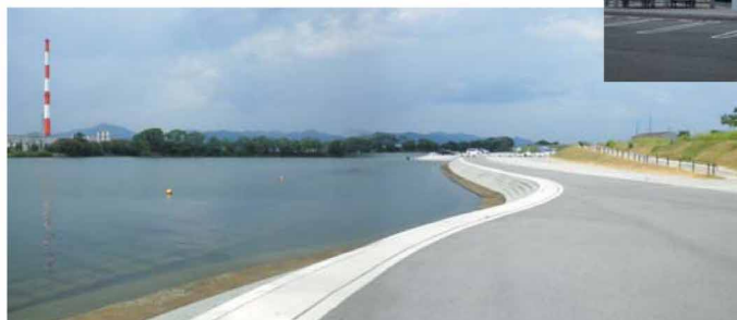
穏やかに流れる今切川の堤防に沿って約1kmにわたって水辺の護岸とスロープが整備されています。また、魚をイメージしたアクアプラザは、隣接する休憩所となっている。
